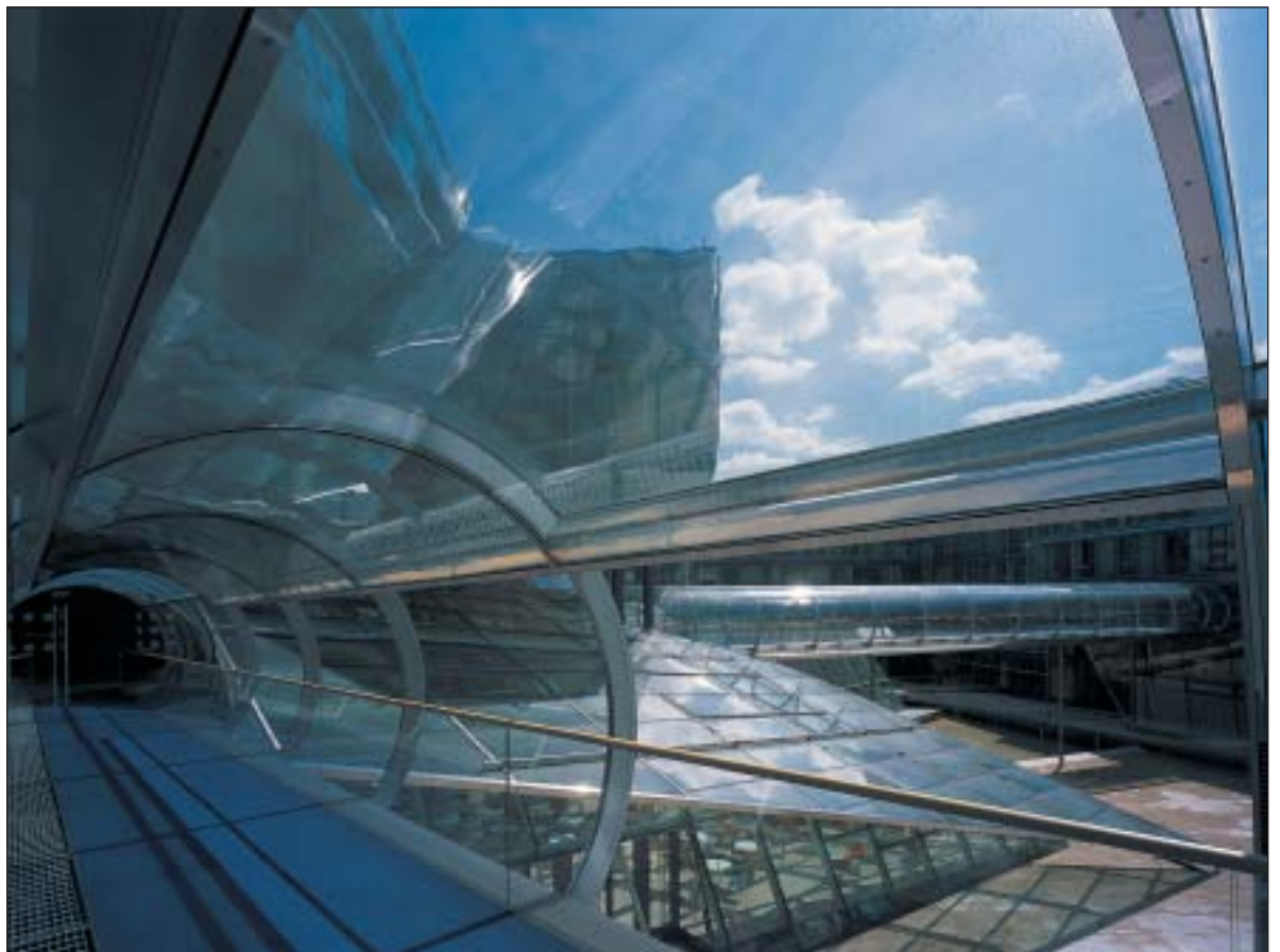
Nord-LB Hannover Spezielles Biegeverfahren von HERO-FORM garantiert die Einhaltung geringster Toleranzen
