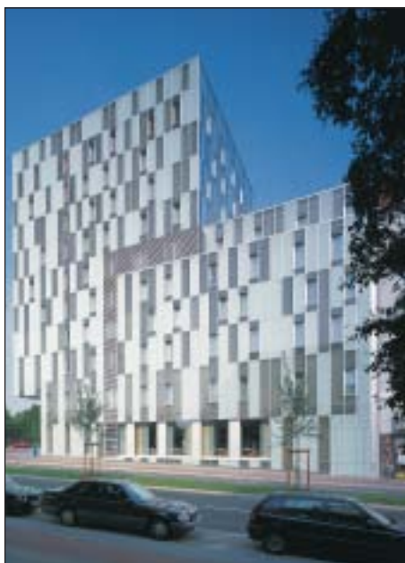
Dorint Hotel Hamburg Fassadengestaltung mit HERO-SUN und HERO-DUR-COLOR-Siebdruck
