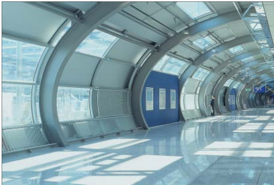
Fernbahnhof Frankfurt/Main: A3 Autobahnüberführung vom ICE-Bahnhof zum Flughafen. HERO-FORM gebogenes Multifunktionsglas
